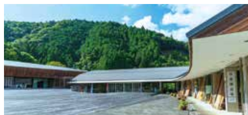
開放的な空間と杉板を張った中庭が特徴のふれあいセンターいずみ。
