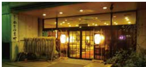
山都町の中心部・浜町にあり、結婚式場も備えています。
